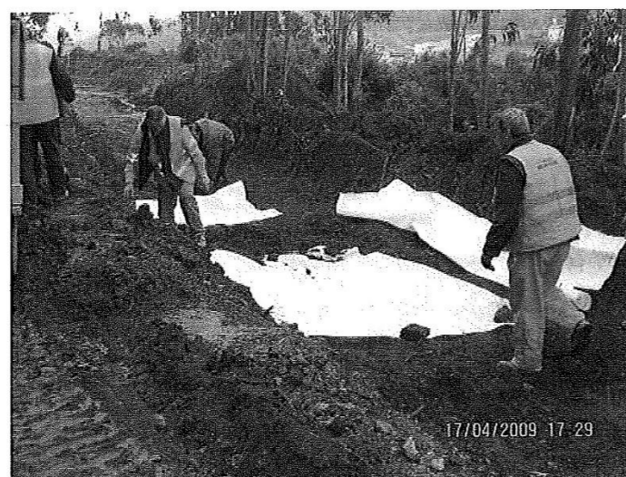
Foto 23.- Colocación de geotextil, previamente al aporte de tierra sobre el yacimiento descubierto.
