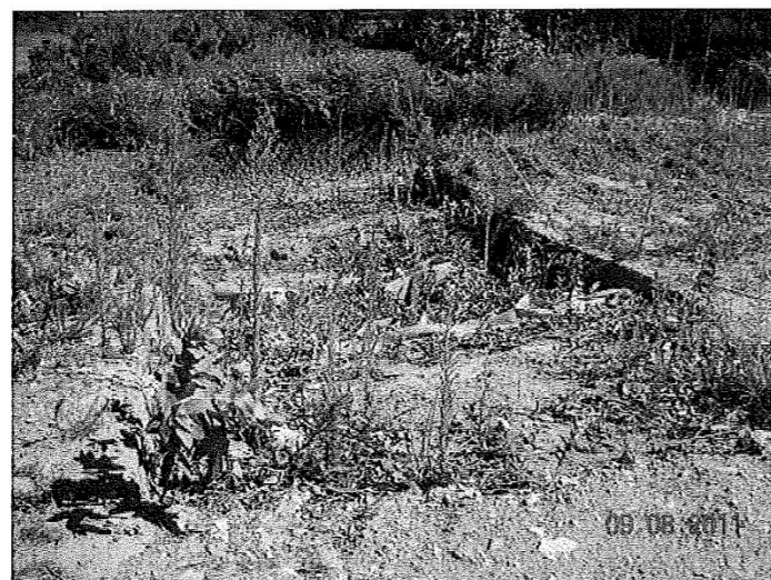
Foto 34.- Primera zona excavada en sentido N-S. Evolución de la vegetación y deterioro en la colocación del geotextil.
