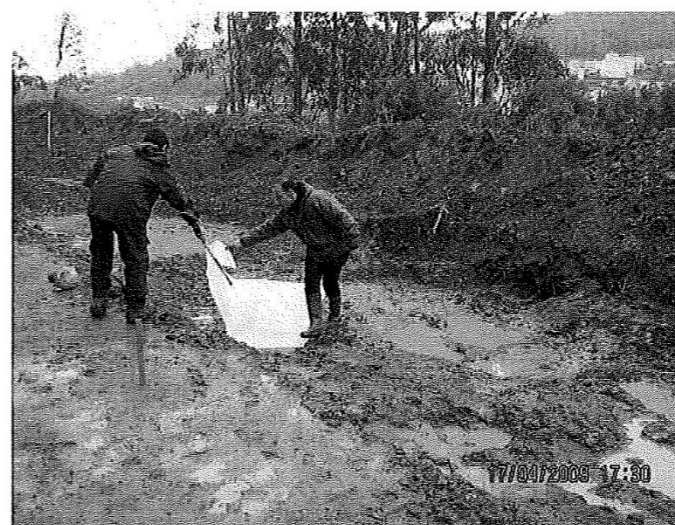
Foto 22.- Colocación de geotextil, para la protección del yacimiento descubierto.
