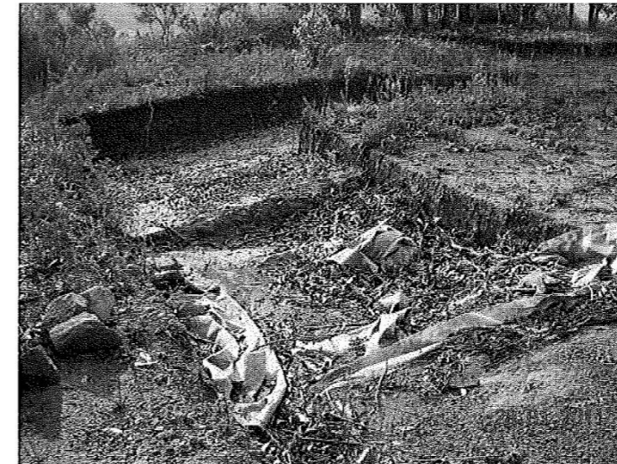
Foto 33.- Primera zona excavada en sentido N-S. Deterioro en la colocación del geotextil.
