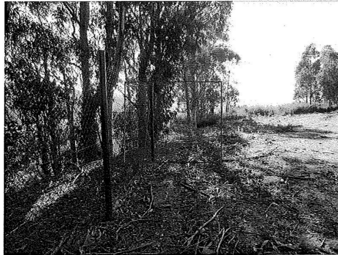
Foto 46.- Zona donde finaliza el cierre perimetral definitivo.
