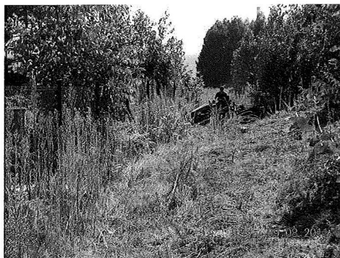
Foto 42.- Trabajos de desbroce con máquina en superficie contigua a la zona de cautela.
