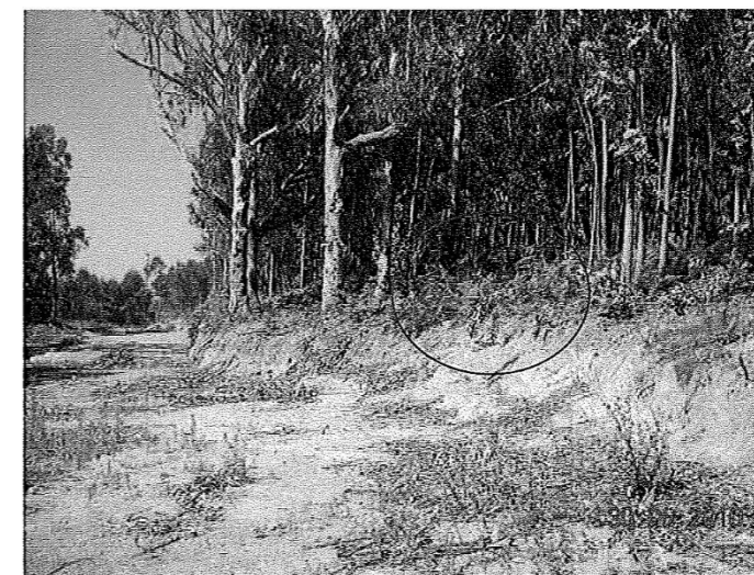
Foto 41.- Trabajos de desbroce manual en zona de cautela.
